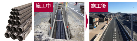
角型TACレックス(角型多条敷設管) 無電柱化の推進(電線の地中化)に貢献
