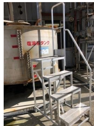
作業ステップへの手すり設置
